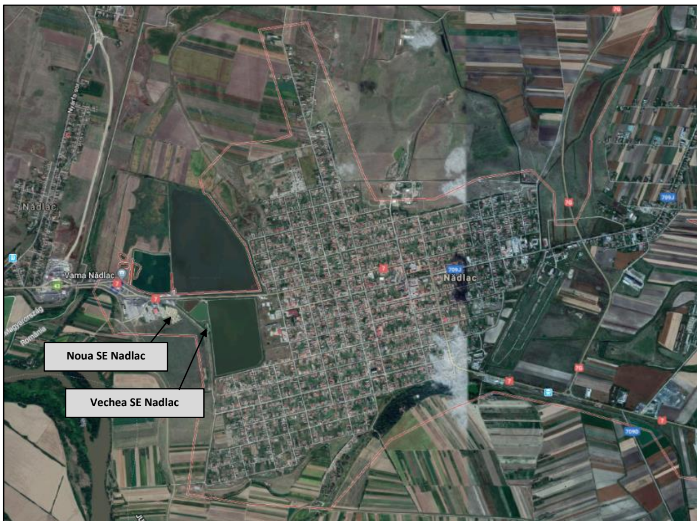
Figura 4.188. Statia de epurare Nadlac – incadrare in zona (sursa: Internet, Google Maps)
