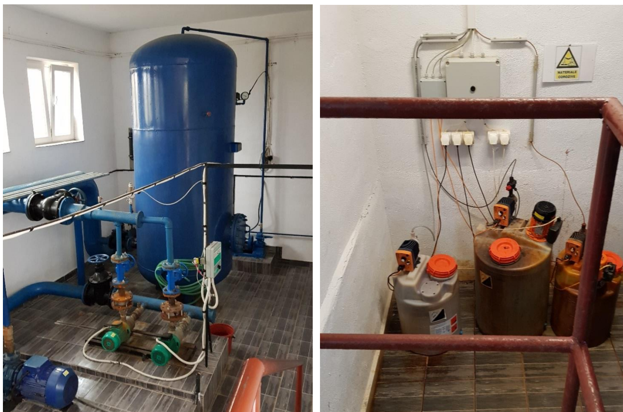
Figura 4.103. Statia de tratare Cermei (stanga: filtre rapide sub presiune, dreapta: statia de reactivi).
