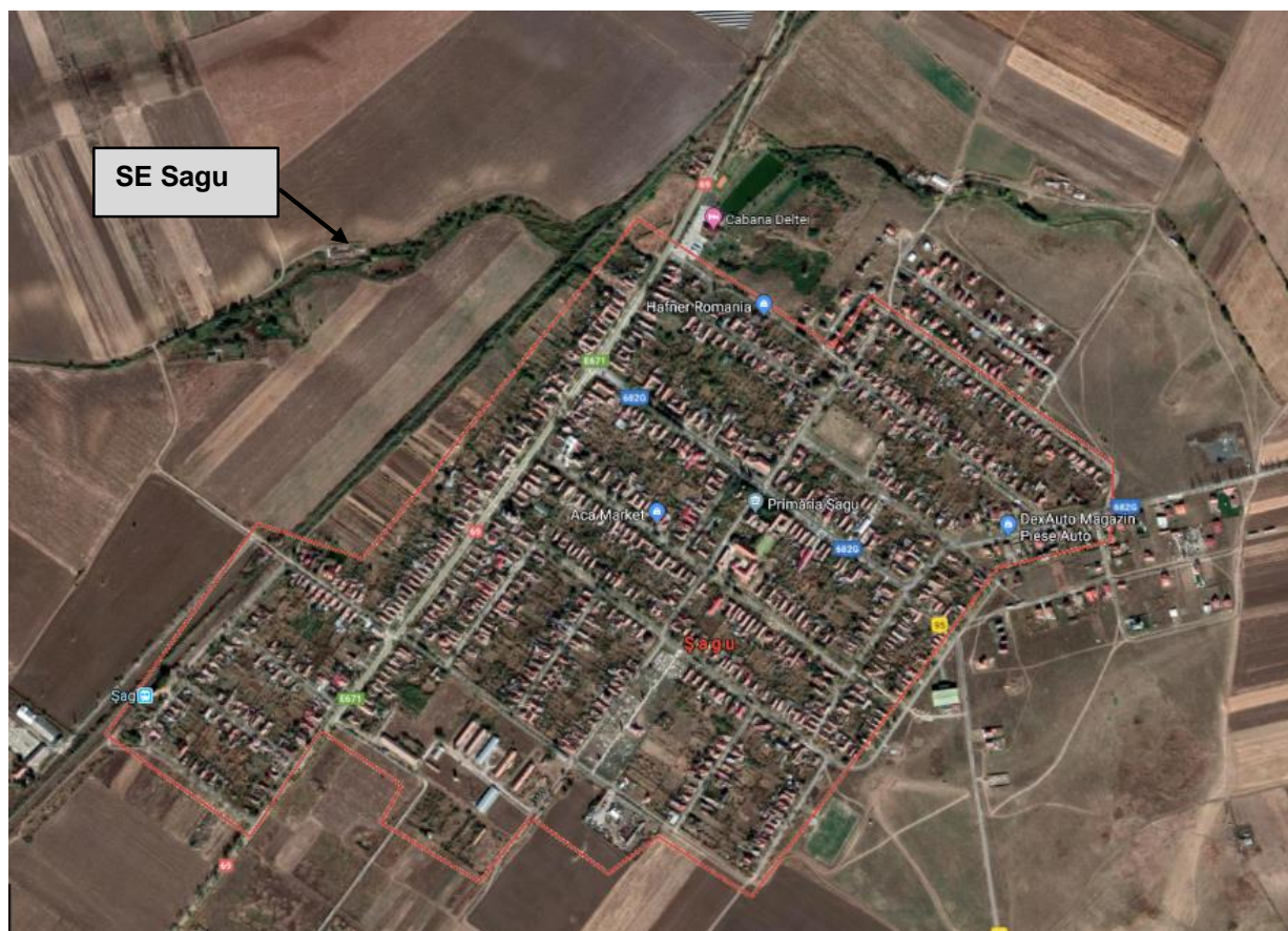
Figura 4.179. Statia de epurare Sagu - amplasare in zona
