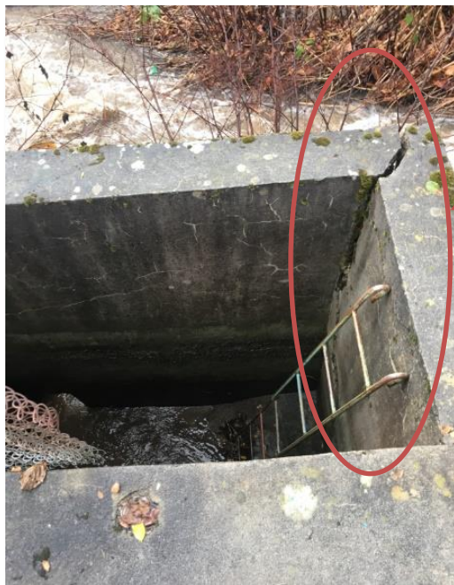
Figura 4.62. Priza de apa Halmagel – Degradari structurare.
