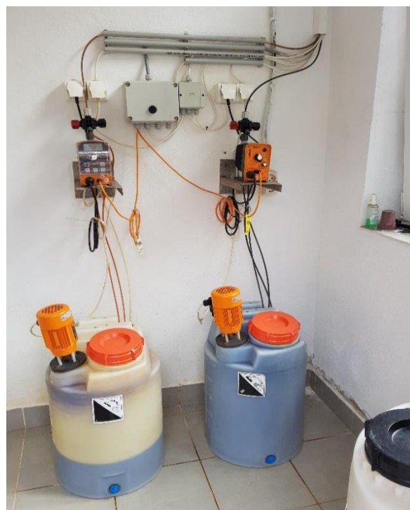
Figura 4.107. Statia de tratare Sereus (stanga: filtre rapide sub presiune, dreapta: statia de reactivi).
