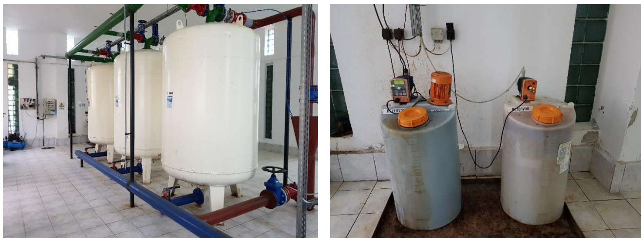
Figura 4.123. Statia de tratare Bocsig (stanga: filtre rapide sub presiune, dreapta: statia de reactivi).
