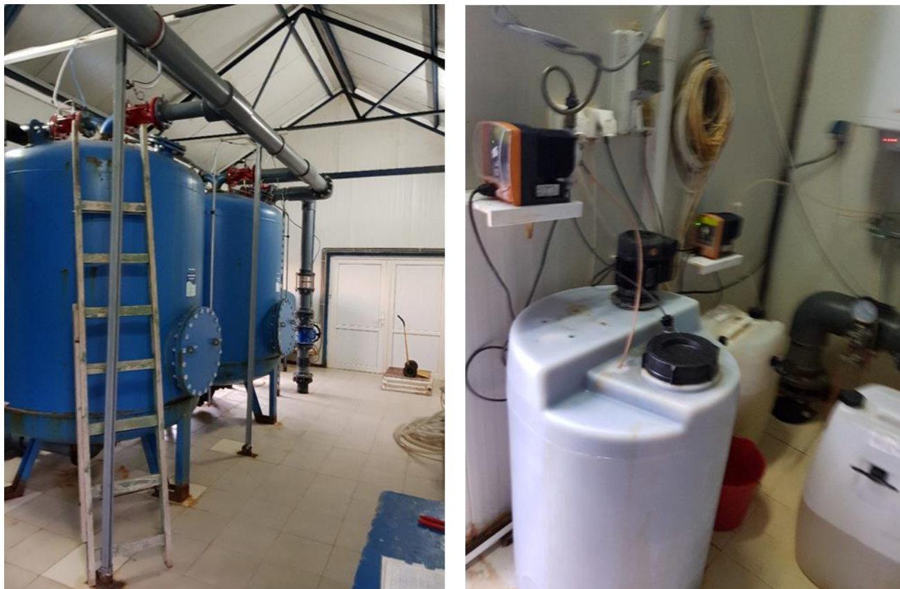
Figura 4.128. Statia de tratare Pancota (stanga: filtre rapide sub presiune, dreapta: statia de reactivi).
