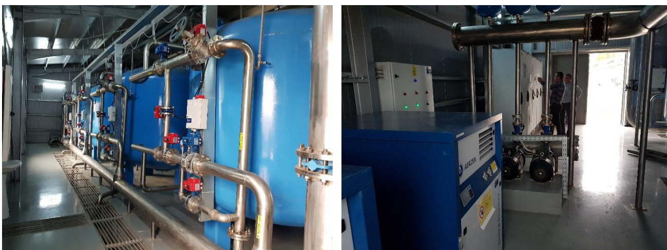
Figura 4.117. Statia de tratare Ineu (stanga: filtre rapide sub presiune, dreapta: suflante si tablouri electrice).
