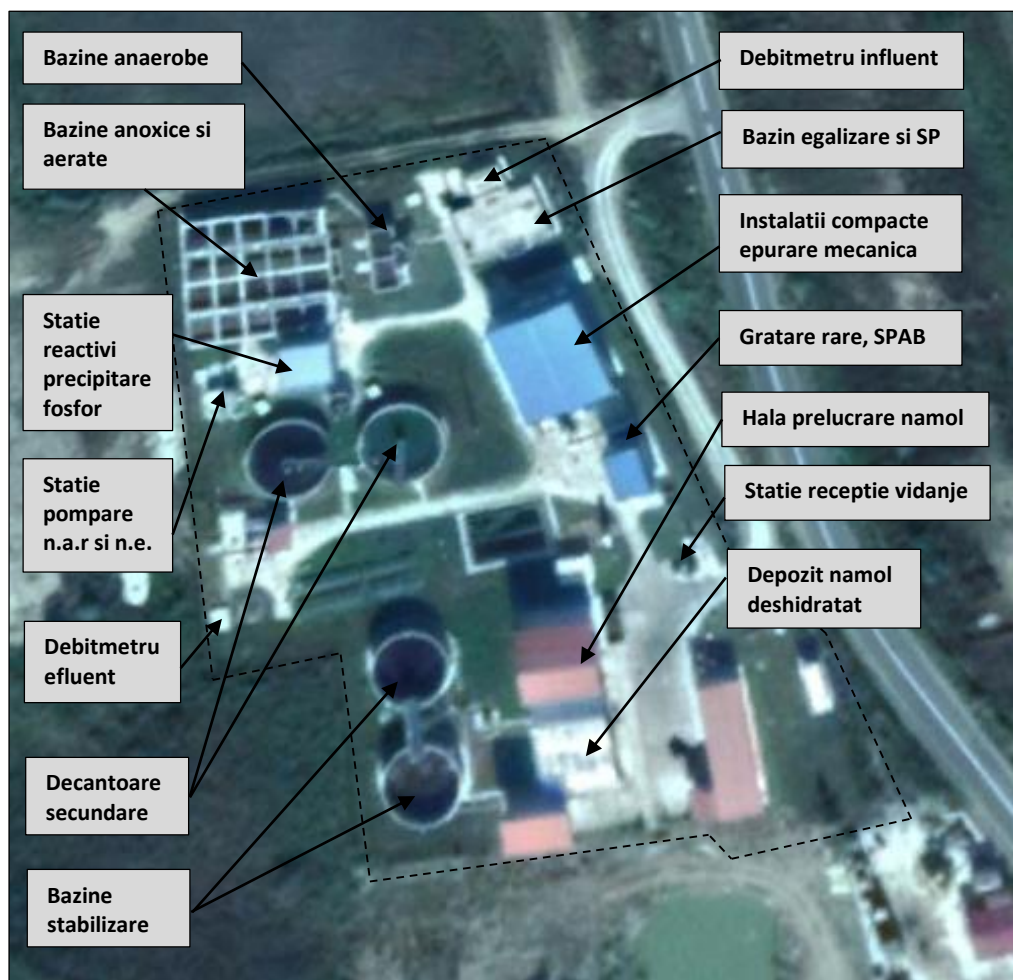
Figura 4.174. Statia de epurare Pecica – vedere de ansamblu (sursa: Internet)
