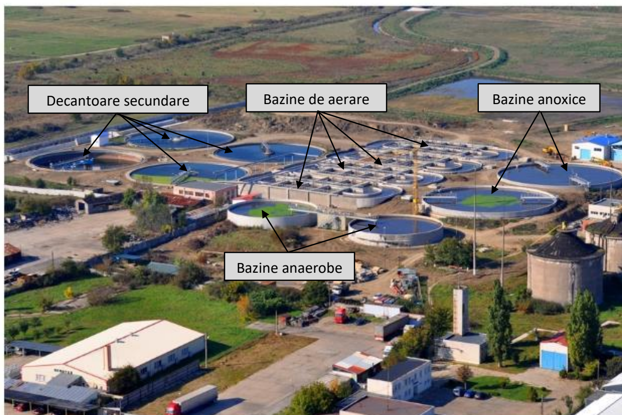
Figura 4.134. Statia de epurare Arad – vedere de ansamblu treapta biologica si bazine de retentie (sursa: Internet)
